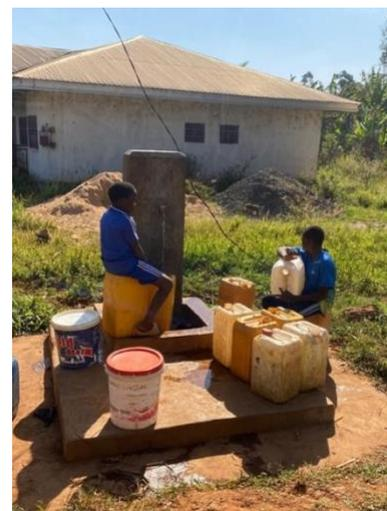
Le projet d'eau de Bambui consistait à forer, à construire un réservoir d'eau, à installer deux réservoirs d'eau de 5 000 litres chacun, à raccorder une pompe solaire et à construire deux arrivées d'eau. Le forage a une profondeur de 80 mètres et garantit de l'eau toute l'année, surtout pendant la saison sèche. Les robinets d'eau sont installés à côté du Foyer sur la route principale, permettant à des milliers d'enfants d'accéder à l'école et à l'université.
