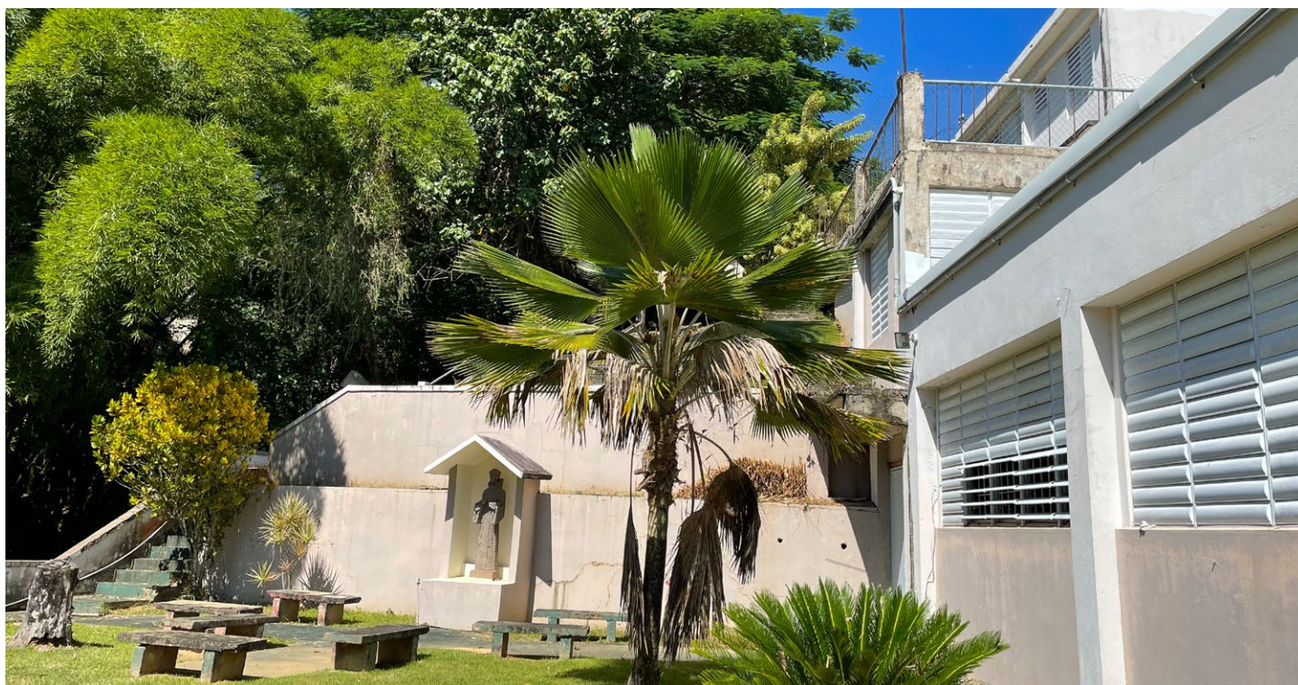
Quattro piani de La Casa abbracciano il lato verso la montagna.
