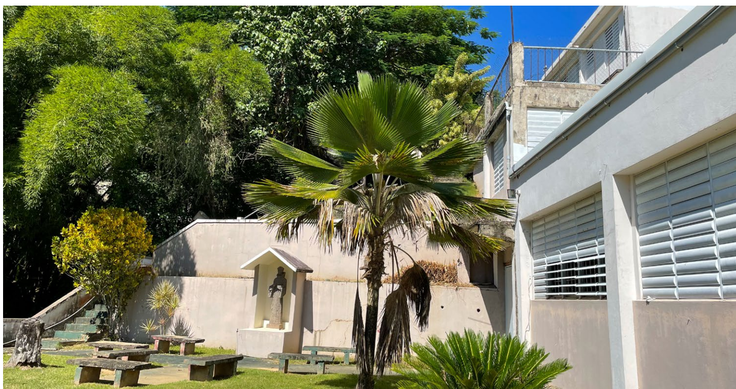
Quatre étages de « La Casa » embrassent le flanc de la montagne.
